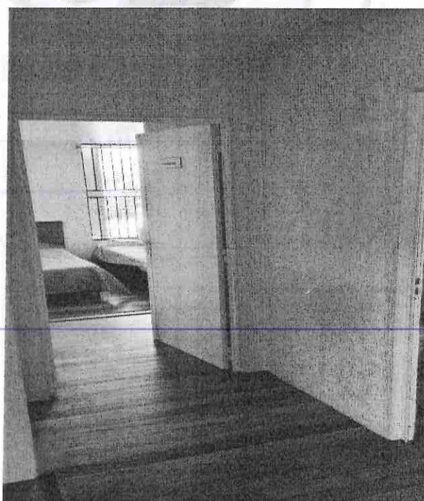
Corredor de acesso a um dos dormitórios.
