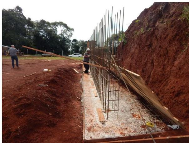
Figura 31: Estrutura de contenção da rampa do novo Transbordo de Ijuí; 11 de maio 2017;
