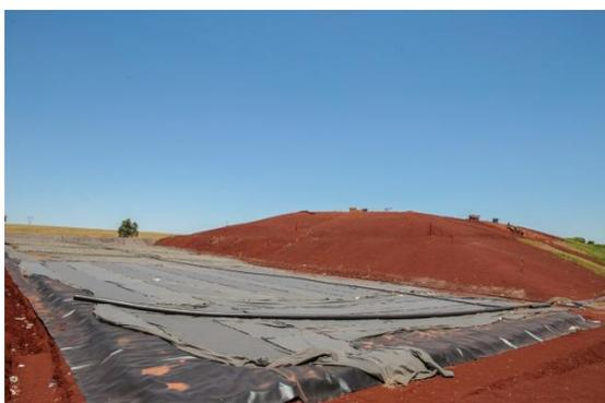
Figura 48: Preparação da Base da Célula da Central de Tratamento de Resíduos de Giruá.
