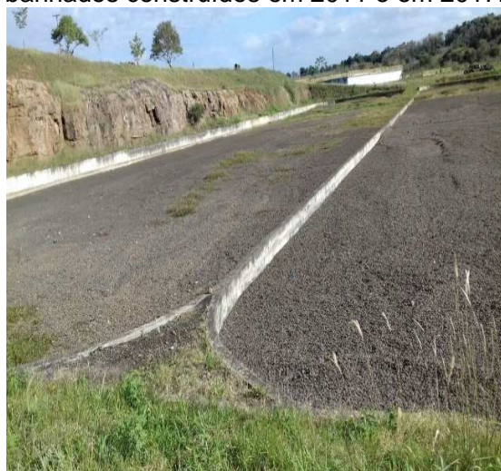
Sistema de banhados construídos em 2017.
