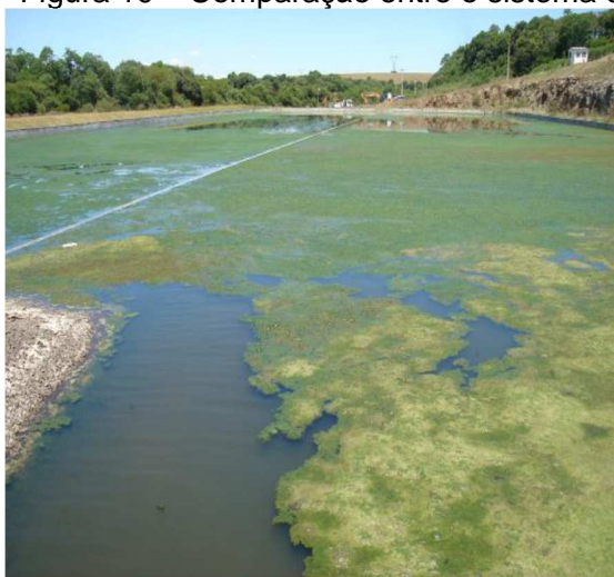
Sistema de banhados construídos em 2011.
