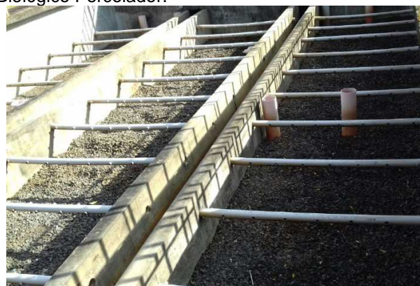
Vista do FBP em outro ângulo, destacando os tubos de ventilação.
