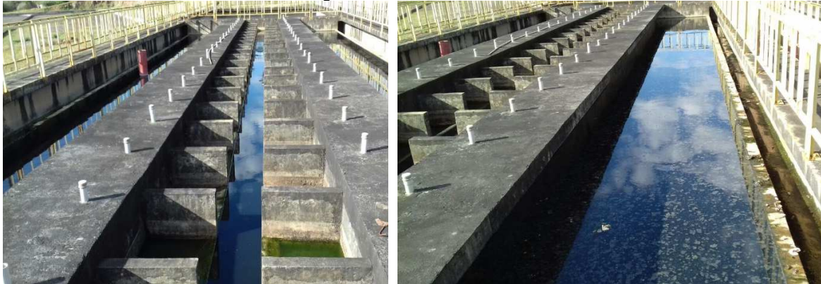
Canais de distribuição do reator UASB.
