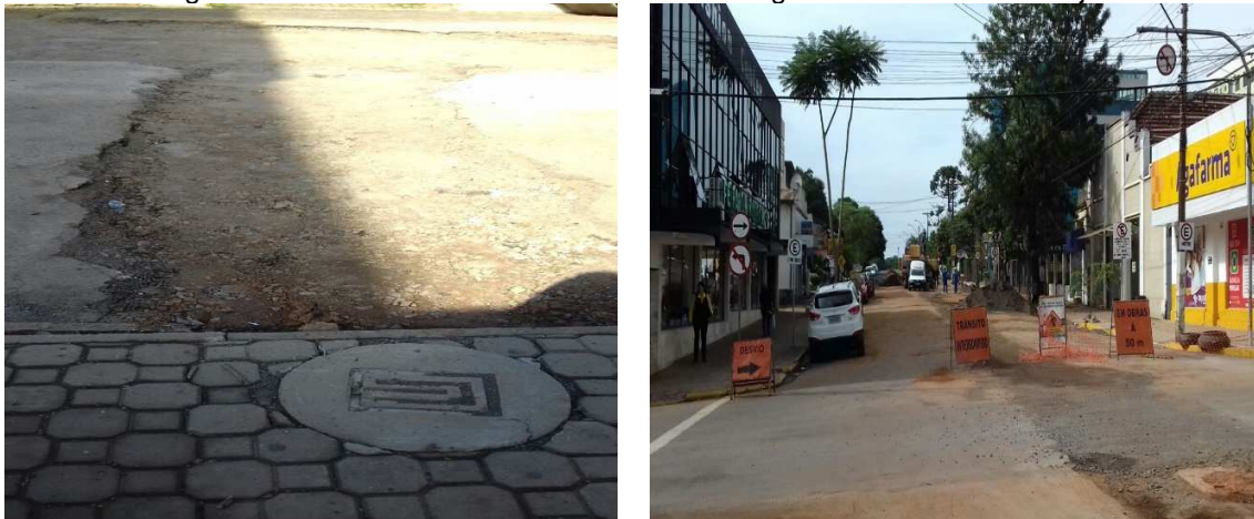
Figura 4 - Assentamento de rede coletora de esgotamento sanitário de Ijuí.
