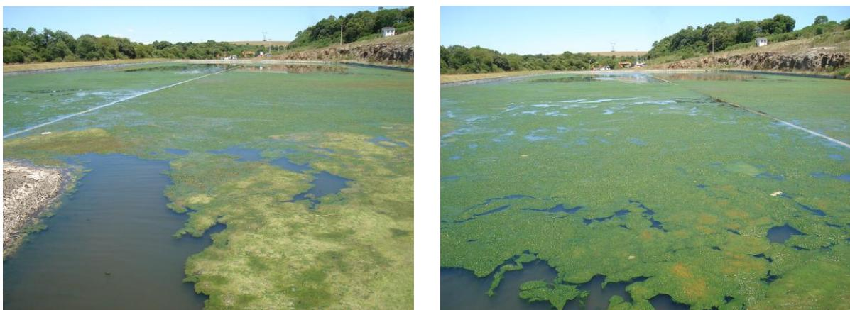
Figura 12: Vistas dos banhados construídos, funcionando como lagoas eutrofizadas e cheias de algas.
