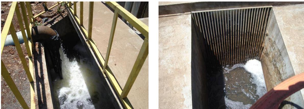
Figura 5: Chegada de água do arroio do Moinho na ETE e grade para remoção de sólidos grosseiros.
