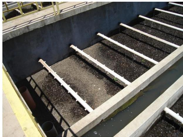
Figura 9: Superfície do filtro biológico retangular e distribuidores. Observar áreas sem recebimento de esgotos, inclusive com crescimento de vegetação.
