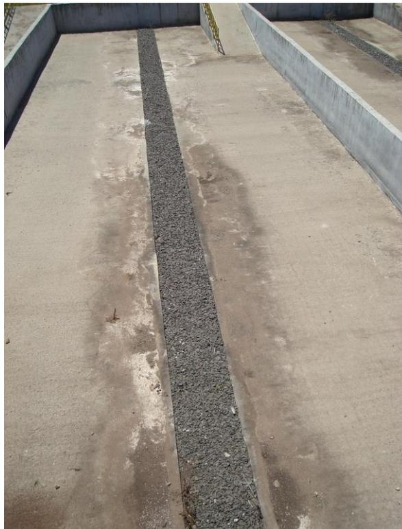
Figura 8: Detalhes do canal de distribuição de esgotos no UASB, assoreado por sedimentos e algas (esquerda). Vista do leito de secagem, com brita no canal de drenagem (direita).
