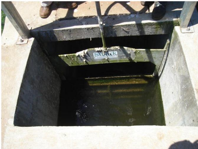
Figura 14: Comporta de regulação de saída do efluente do banhado.
