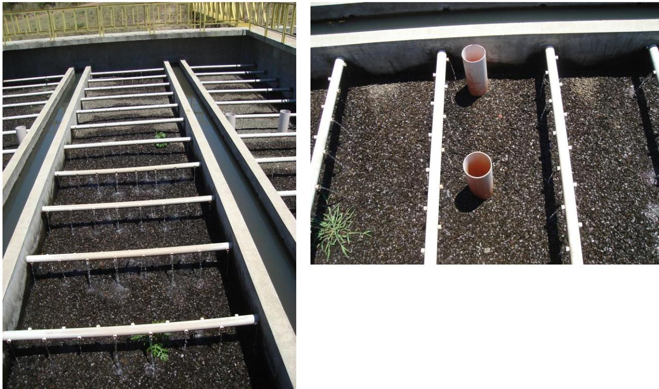
Figura 10: Imagens do FB, canal de chegada, distribuidores de esgotos e tubos ventiladores.
