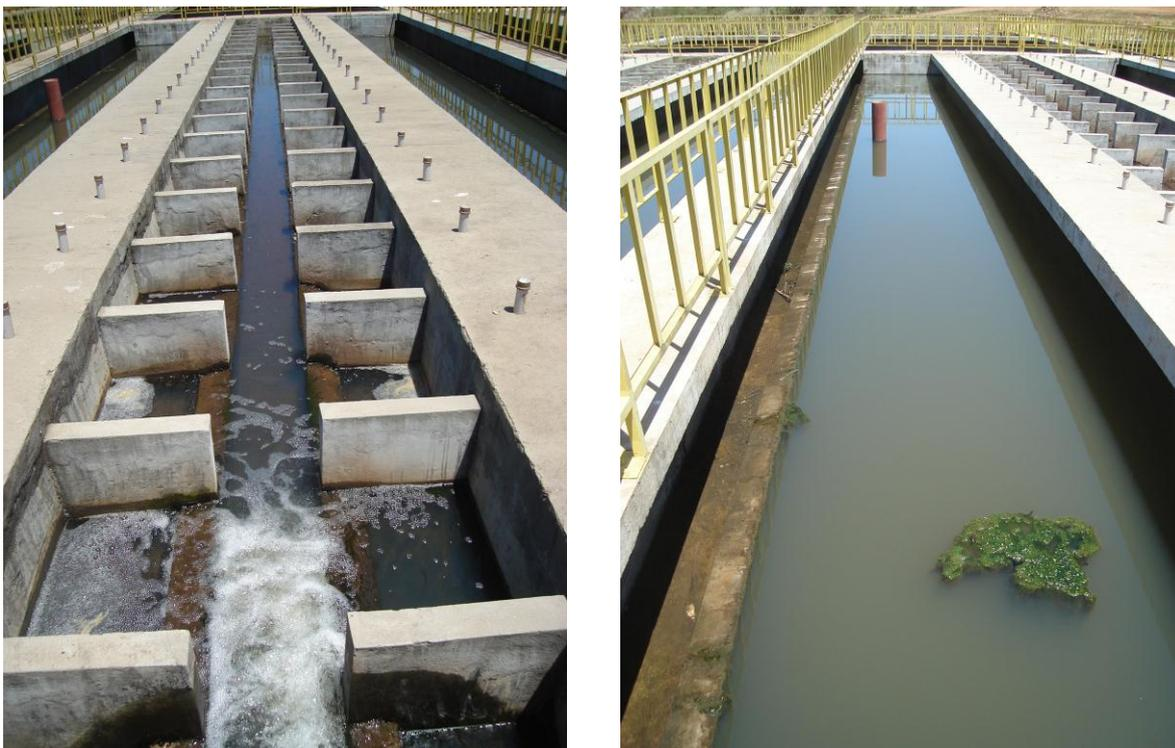
Figura 7: Ilustrações do reator UASB. À esquerda, o canal de entrada e distribuição; à direita, o efluente decantado. Observar o agregado sólido verde flutuando.
