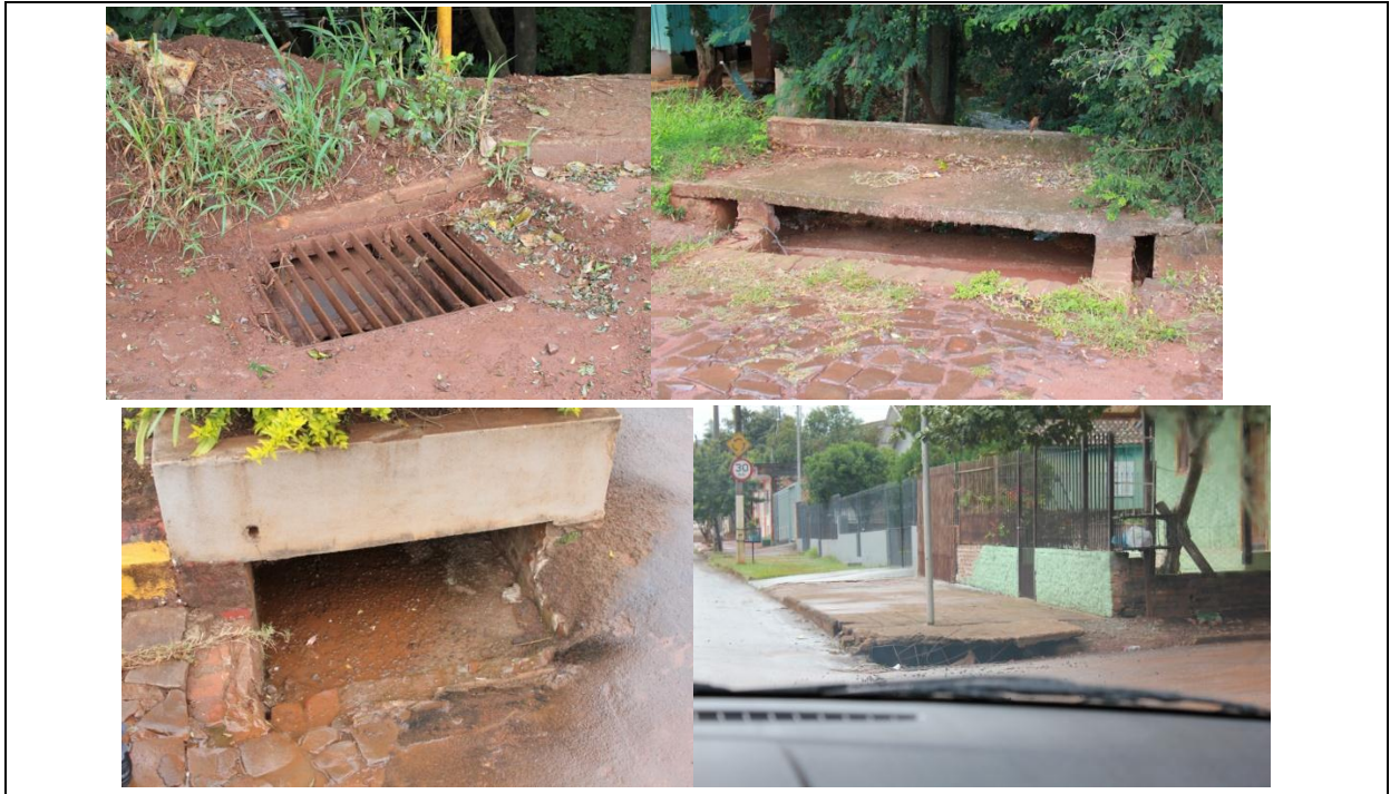
Figura 6.3 – Estruturas de micro drenagem existentes em Ijuí
