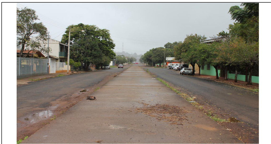
Figura 6.5 – Trecho do arroio Moinho com canal fechado em concreto armado
