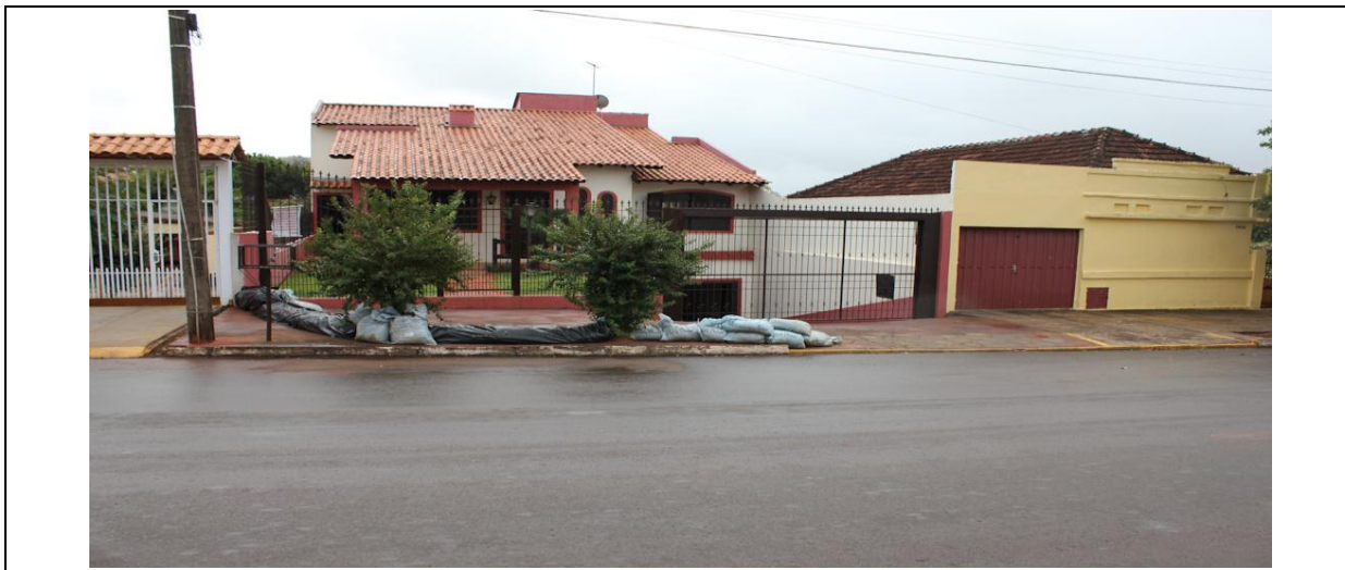
Figura 6.2 – Barreira construída para evitar o ingresso de água em uma residência
