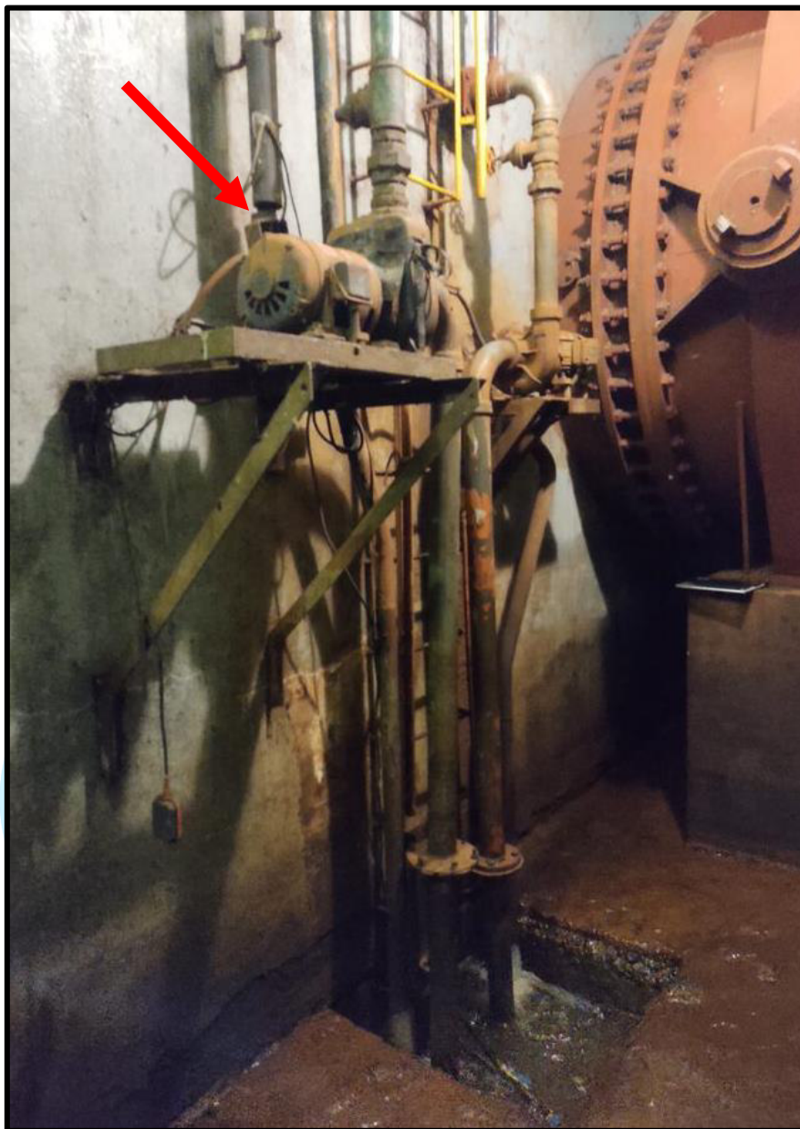
Figura 7 - Ponto de instalação das novas bombas.
