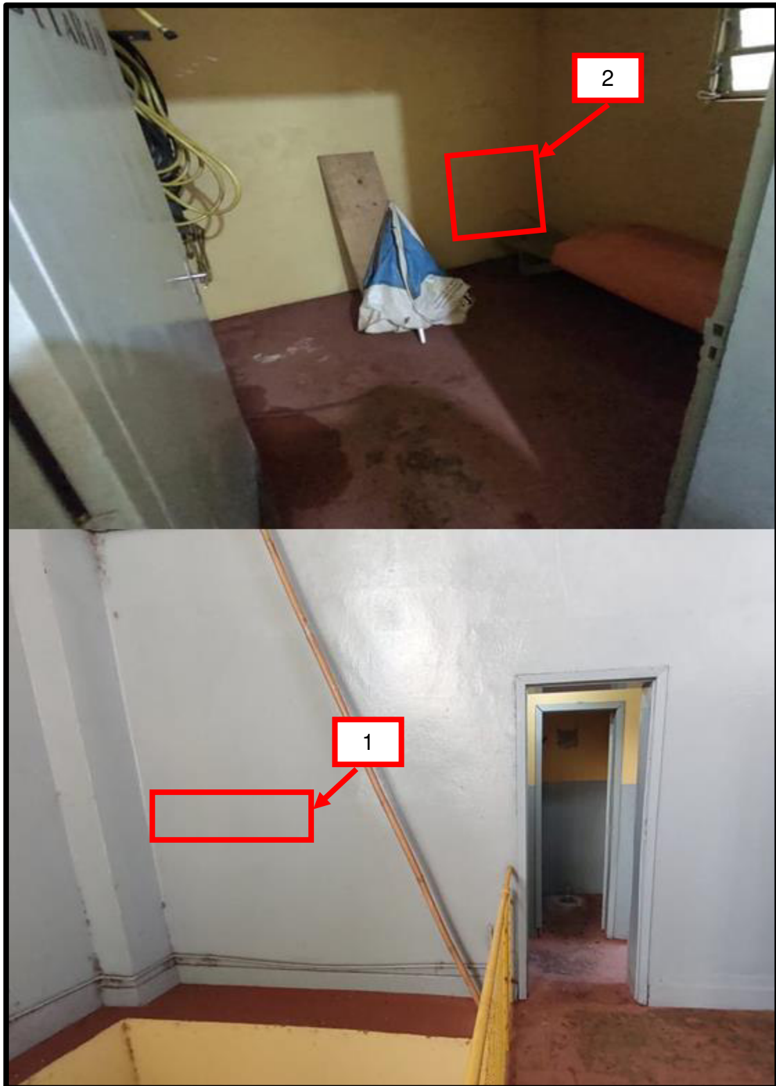
Figura 30 - Ponto de abertura dos buracos para passagem da tubulação.
