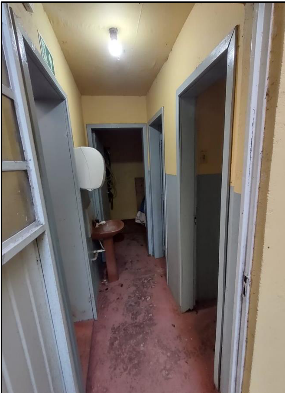
Figura 28 - Paredes internas a serem demolidas.
