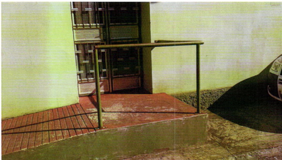
Substituição de corrimão por guarda-corpo com corrimão
