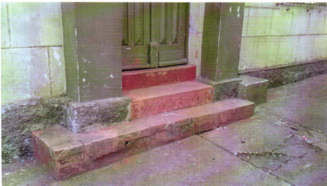
Reconstrução do revestimento dos degraus da escada
