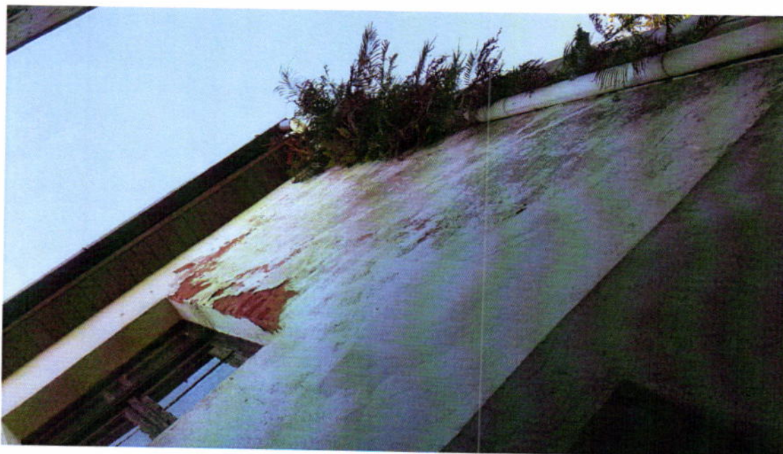
Exemplo do local para remoção de calhas, dutos de queda e limpeza da área para pintura
