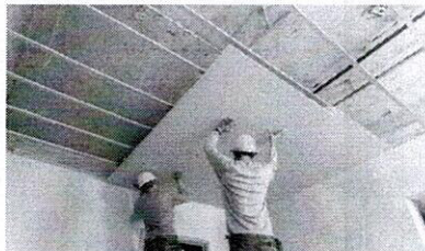
Forro de gesso liso c/ negativos.
