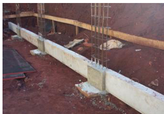
Baldrame sobre sapata isolada.
