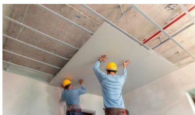
Forro de gesso liso c/ negativos.
